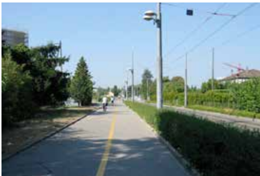
Beispiel Attraktive Lösungen für Veloverkehr entsprechend unterschiedlichen örtlichen Voraussetzungen (Genéve)
