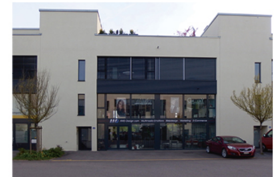
Beispiel Kombination von Wohnen und Arbeiten (KMU-Park Uster)
